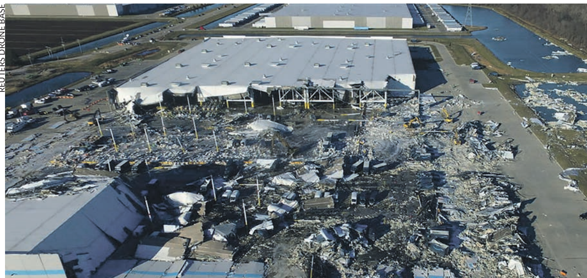
Une partie de l'entrepôt Amazon détruite par la tornade.
