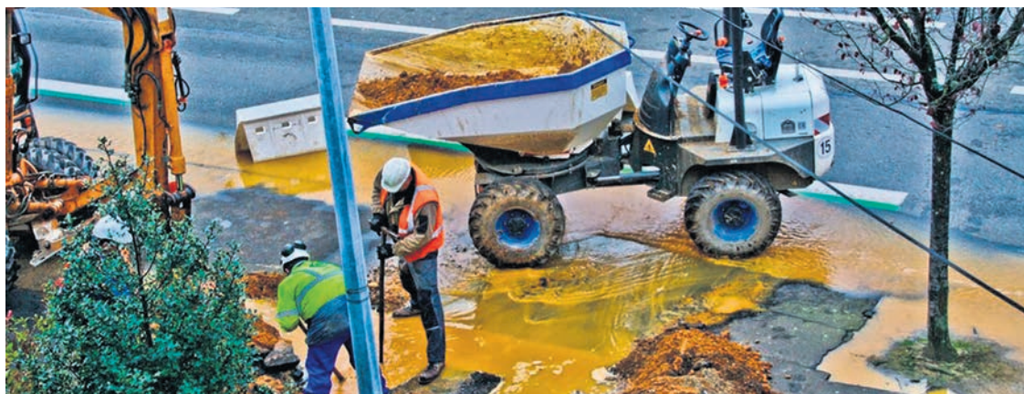
Travaux d'entretien sur une canalisation d'eau.
